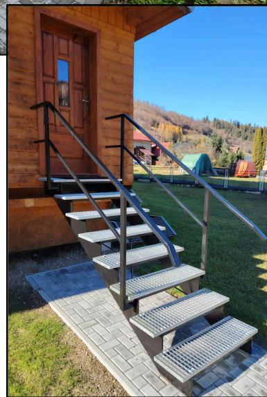
Nové schody do sakristie
