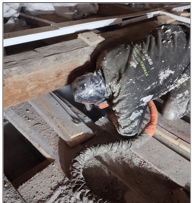
izolovanie stropu - kostol
