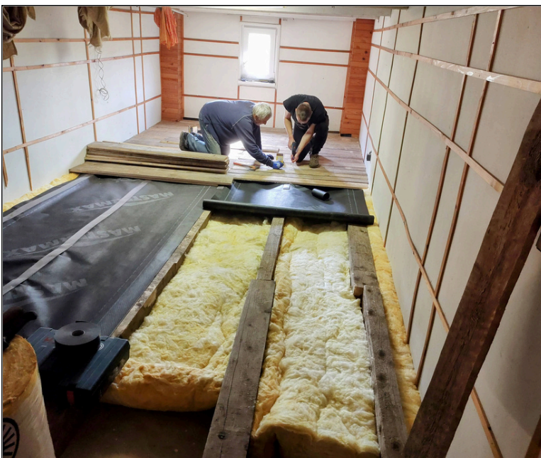
izolovanie stropu - fara
